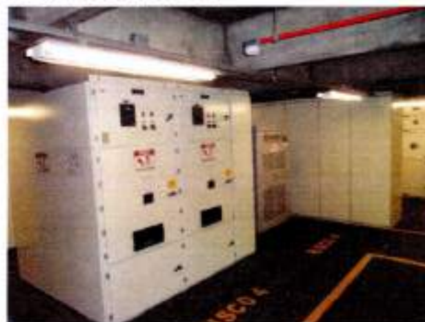
Disjuntor / COMTRAFO 500KVA TRIFASICO
